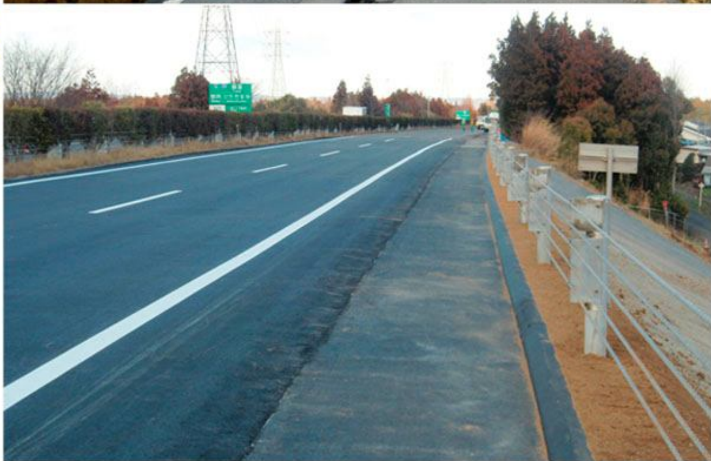
Estrada reconstruída em apenas 6 dias, após o terremoto no Japão em 2011.
